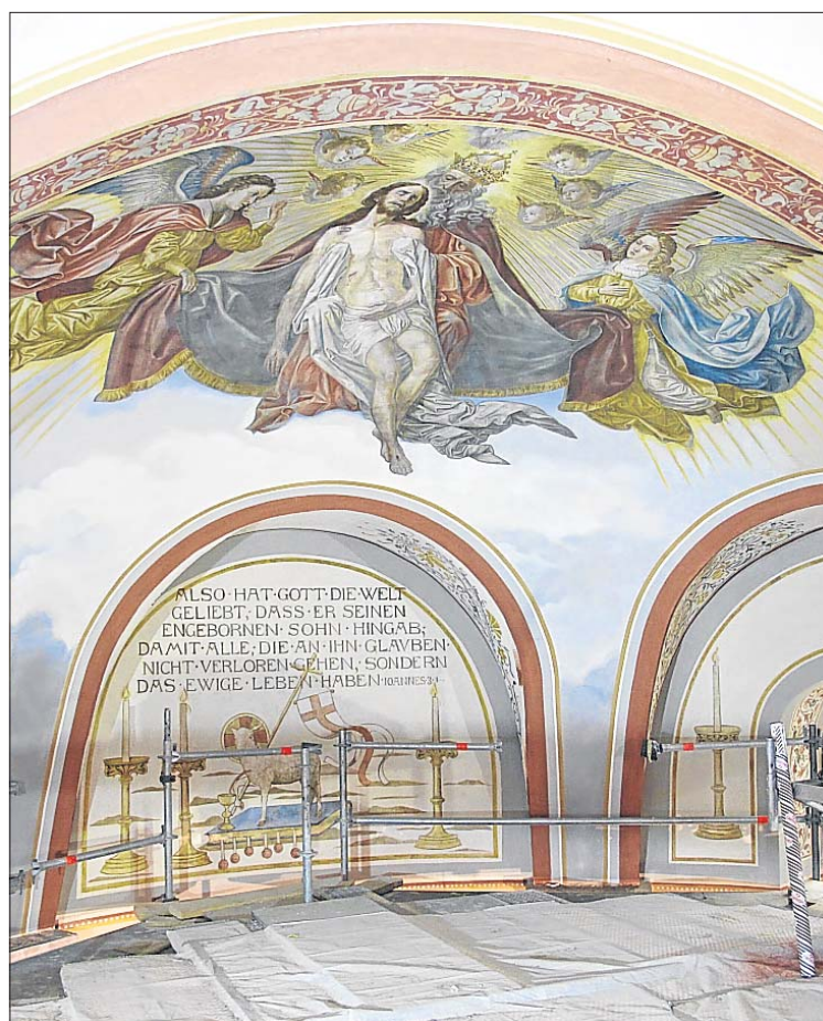
Rechtzeitig vor der Erstkommunionfeier sollen die Arbeiten abgeschlossen sein.
