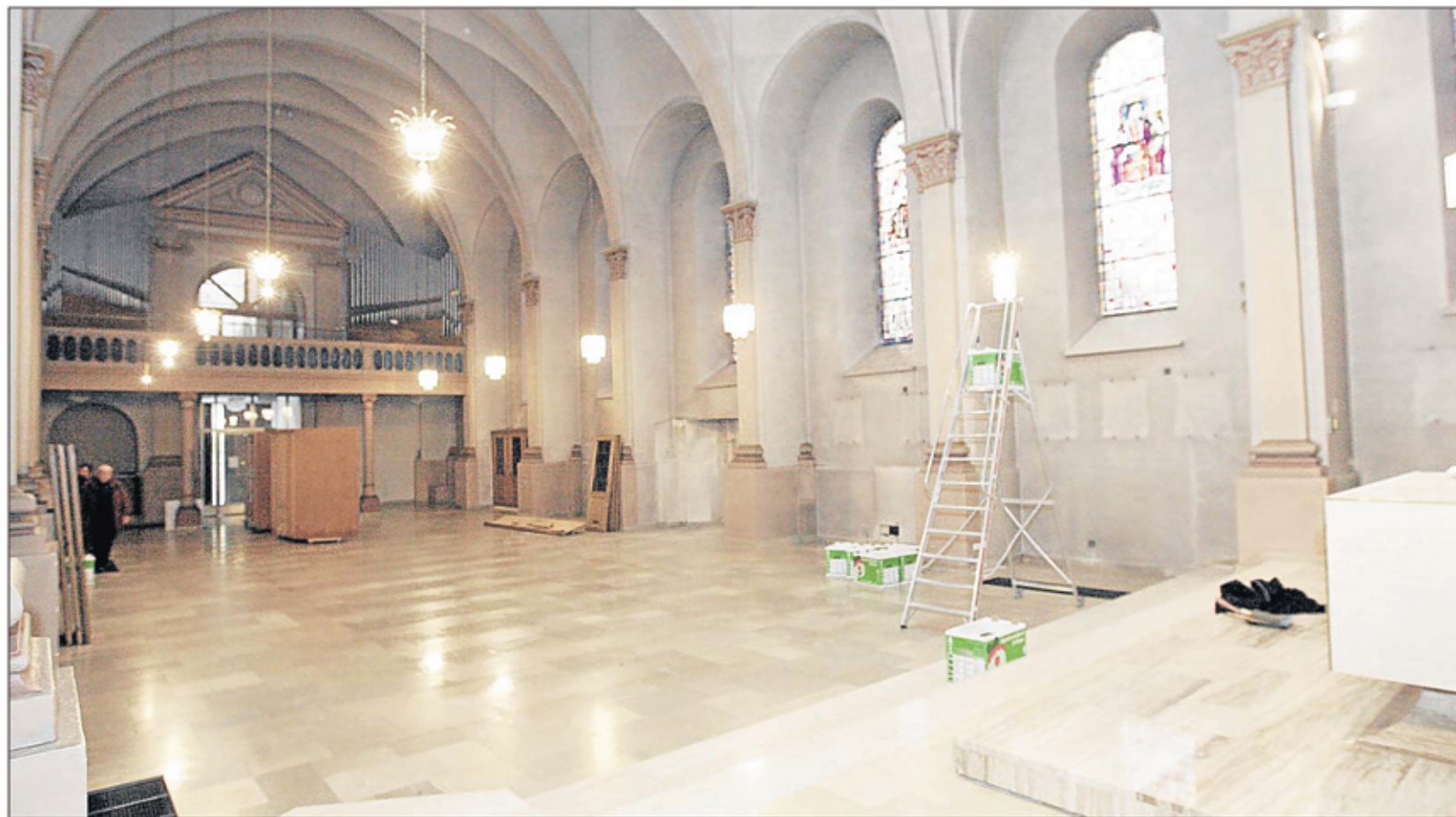
Die durch die Raumluftheizung bedingte graue Patina soll dank des Anstrichs bald der Vergangenheit angehören.
