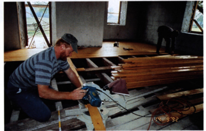
An schattigem Ort bei der Fußbodenverlegung
