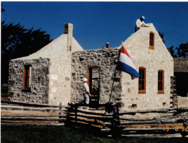
Michel zeigt mit berechtigtem Stolz den fertigen Rohbau
