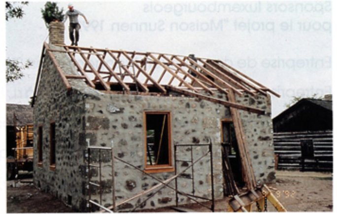
Neues Dachgespärre aus Luxemburg. Schwindelfreier Balanceakt von Guido
